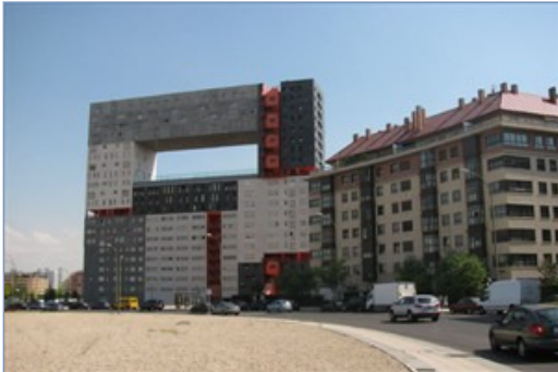
Das "Edificio Mirador" im Stadterweiterungsgebiet Sanchinarro.
