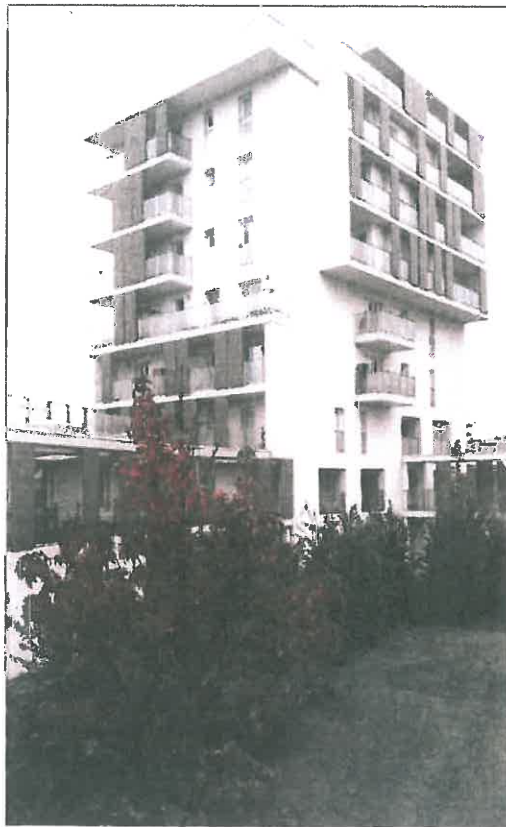
LEISTBARE LÖSUNG Die Wohnanlage „Via Cenni“ bietet eine günstige Alternative zu den allerorts in Mailand sprießenden Luxusvierteln.
