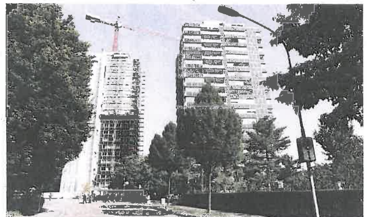
Hochhäuser Sihlweid: Der erste Turm ist bereits fertig, am zweiten Turm wird noch eifrig gearbeitet
