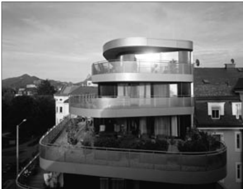
Abbildung 6-2: Halle 1, Fallnhauser-Areal, Bild 2 © „Salzburg“
