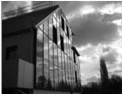
Abbildung 4-5: Südfassade mit Kollektoren © Architekturbüro Reinberg
