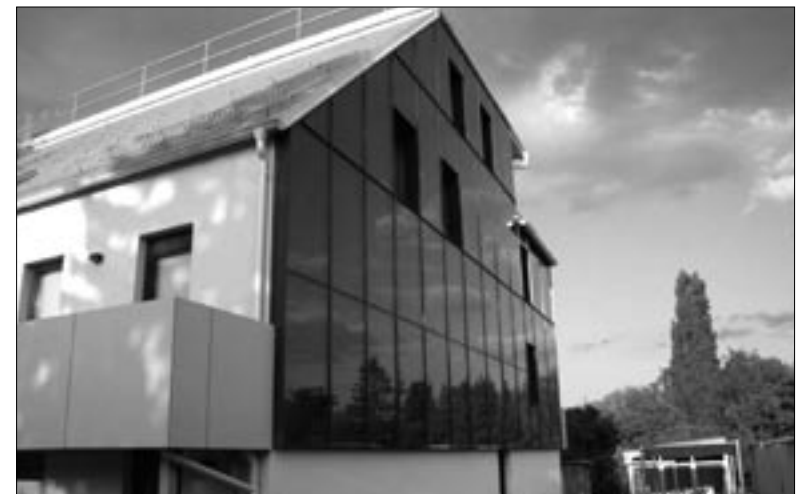
Abbildung 4-10: Südfassade mit Solarkollektoren © Architekturbüro Reinberg
