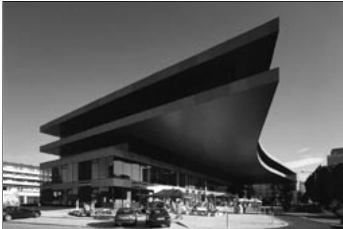
Abbildung 6-4: Halle 1, „Neue-Mitte-Lehen“ © „Salzburg“
